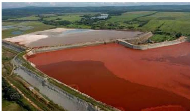
**FIGURA 8** - LAGOA DE DISPOSIÇÃO DE LAMA VERMELHA NA REGIÃO DE BUDAPEST, HUNGRIA. FONTE: EPA/SANDOR, 2006.
