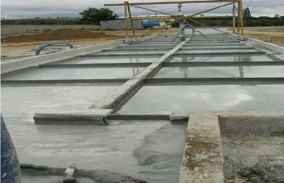
Figura 3.11 – Tanque de Decantação de Resíduos (lama) (SOUSA, 2007).
