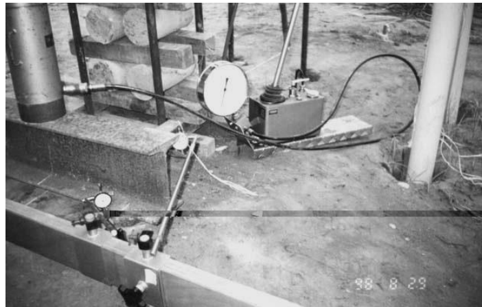
Figura 19 - Macaco utilizado para aplicação das cargas.
